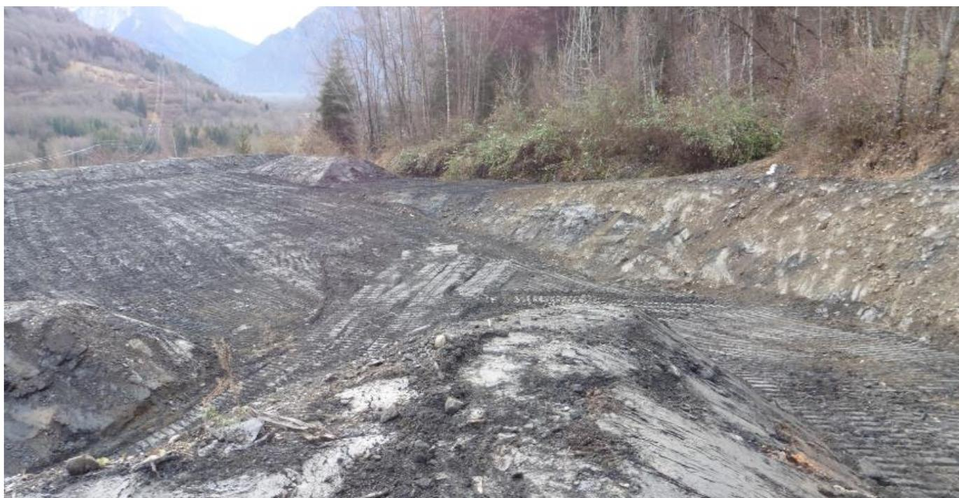
Figure 7 : Terrassements réalisés sur la partie haute des anciennes ardoisières pour le stockages des crues solides (charriage) des Rivets et de Mondane.
